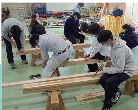
木造建築施工①
